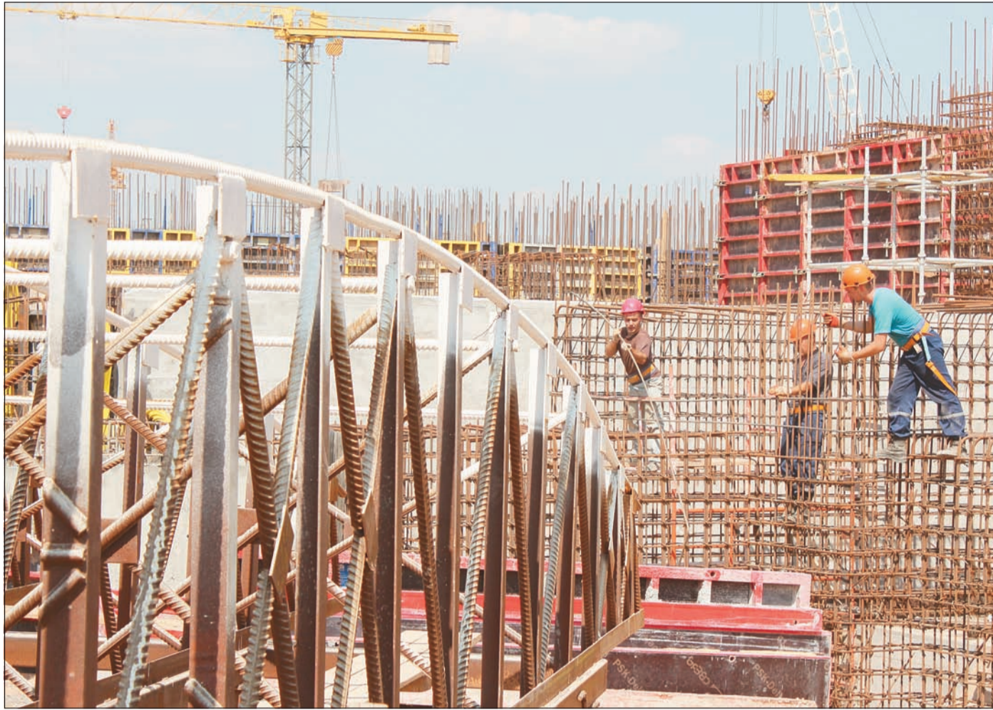
Сегодня численность строительного персонала на площадке возведения Белорусской АЭС превысила 4100 человек
