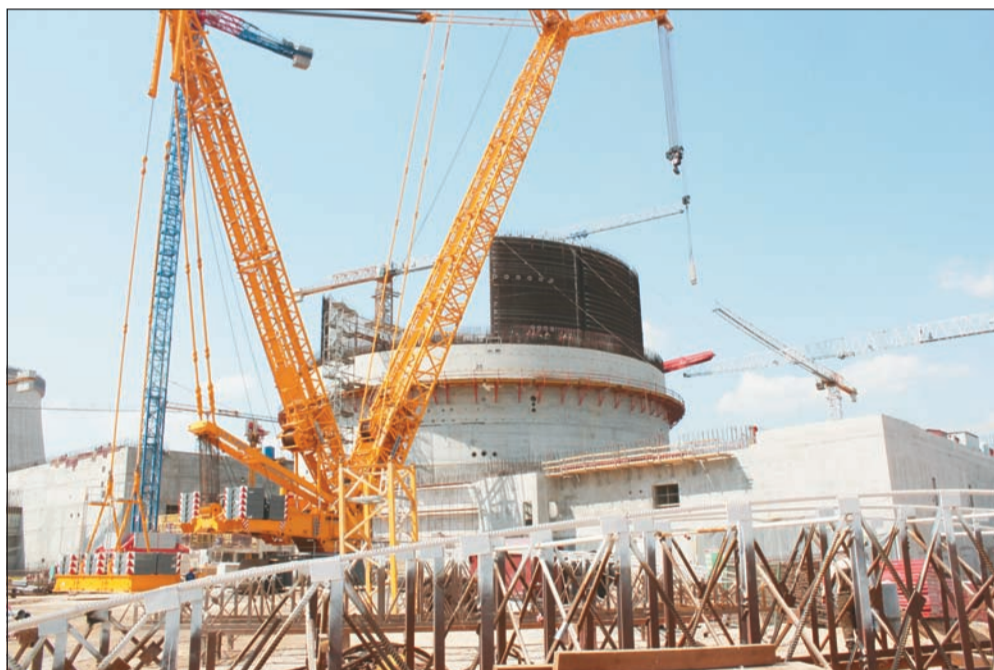
По информации на 1 июля, сооружение внутренней и внешней защитных оболочек реакторного отделения энергоблока №1 было выполнено до отметки +22 метра
