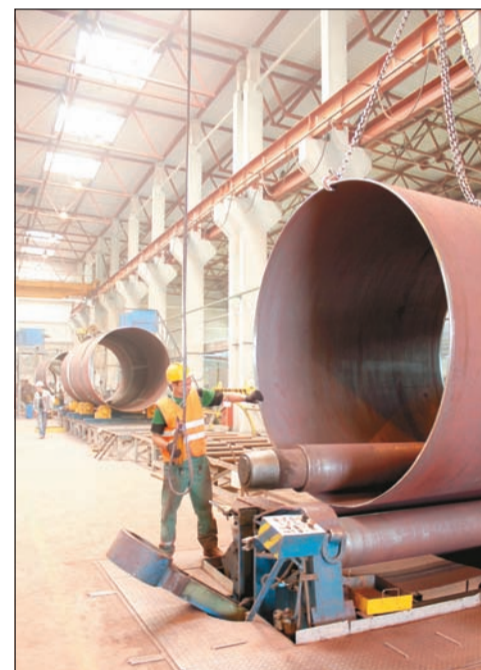
Циркуляционные водоводы для будущей атомной станции изготавливаются на месте, в специальном цехе
